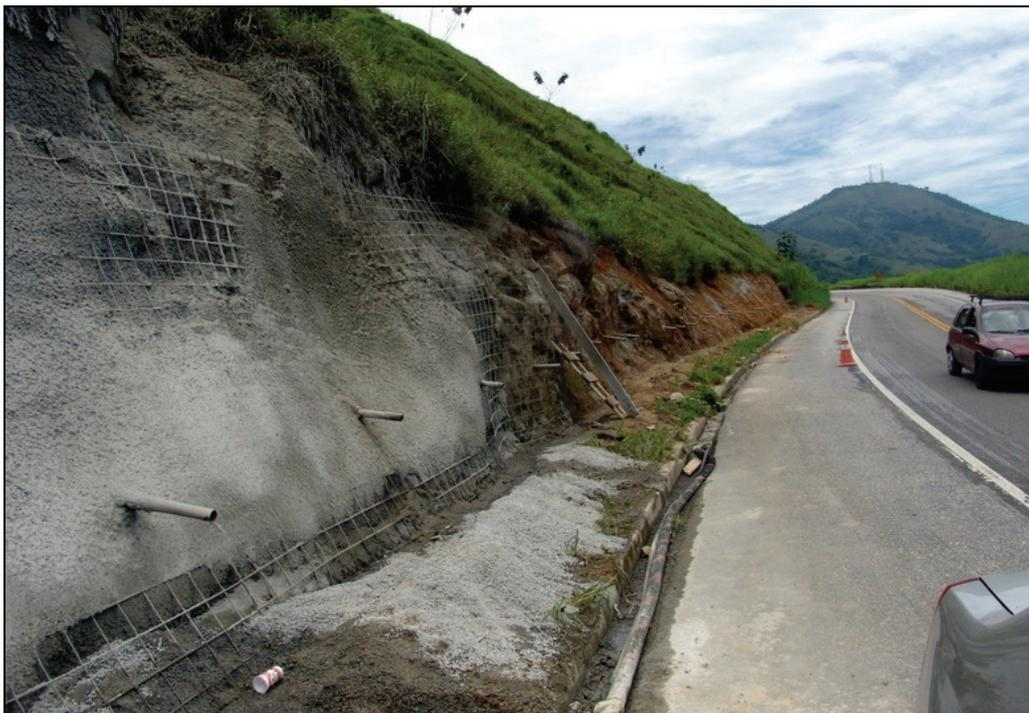
Figura IV.7-30: Obras de contenção de encostas ao longo da BR-101 (Rio-Santos). O trecho entre Mangaratiba e Angra dos Reis é um dos mais susceptíveis a deslizamentos, que afetam a circulação na rodovia e acionam o sistema de alerta do Complexo Nuclear. No final de 2008, três deslizamentos interditaram temporariamente a pista. Segundo o DNIT, a rodovia apresenta pelo menos 27 pontos de deslizamento (Angra dos Reis, fevereiro de 2009)
