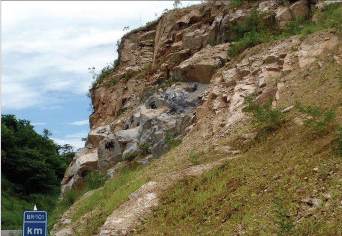
Figura IV.3-34: Encosta com risco de deslizamento (Angra dos Reis, fevereiro de 2009).
